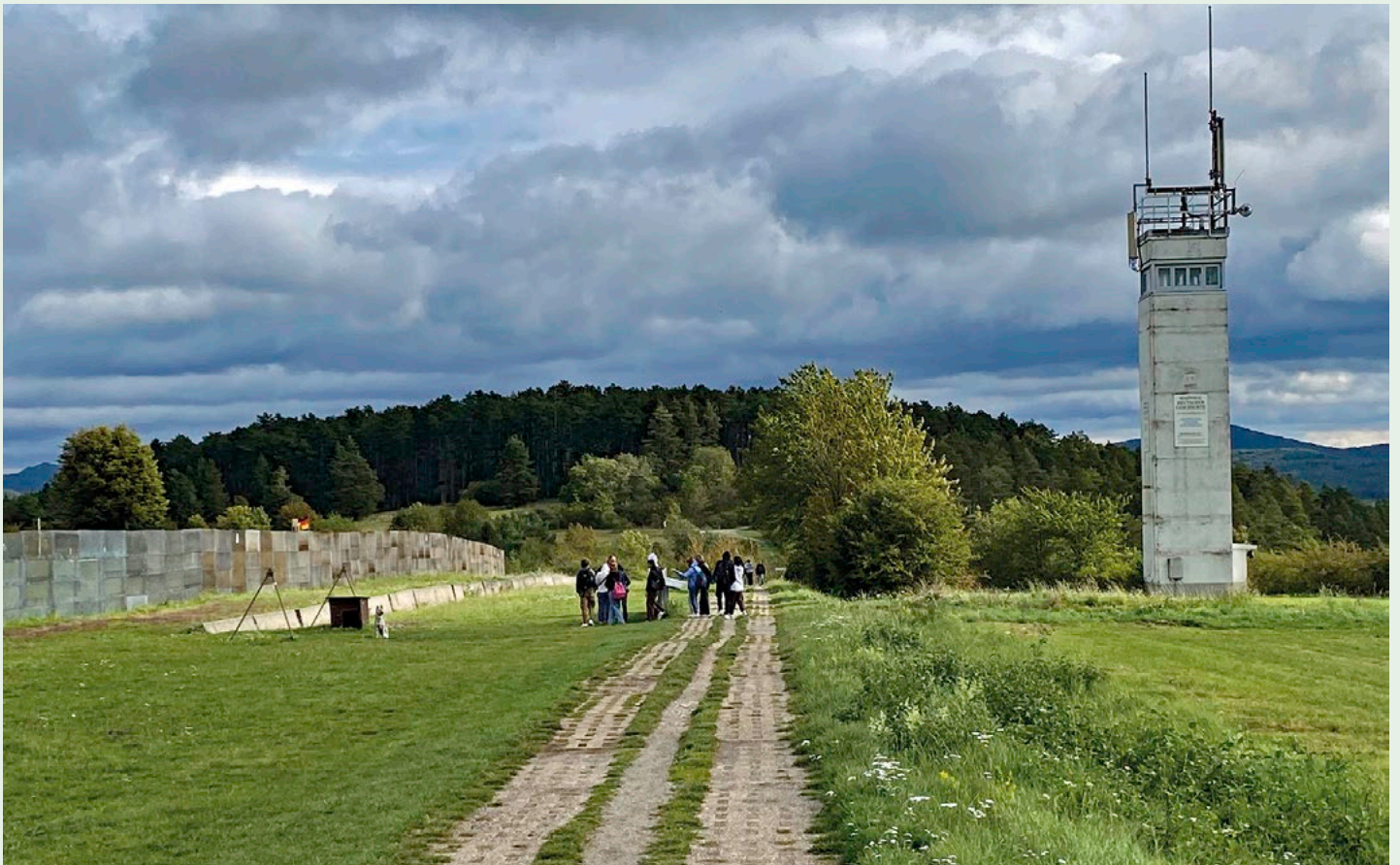
Beeindruckend sind die über 700 m langen, rekonstruierten Grenzsperranlagen bei Point Alpha.
